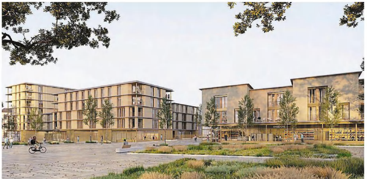
Le projet Matera, avec 81 logements en accession abordable et libre, est la première opération française de logements collectifs R + 6 en béton de chanvre. Image de synthèse Palast et Ramdam Architectes
